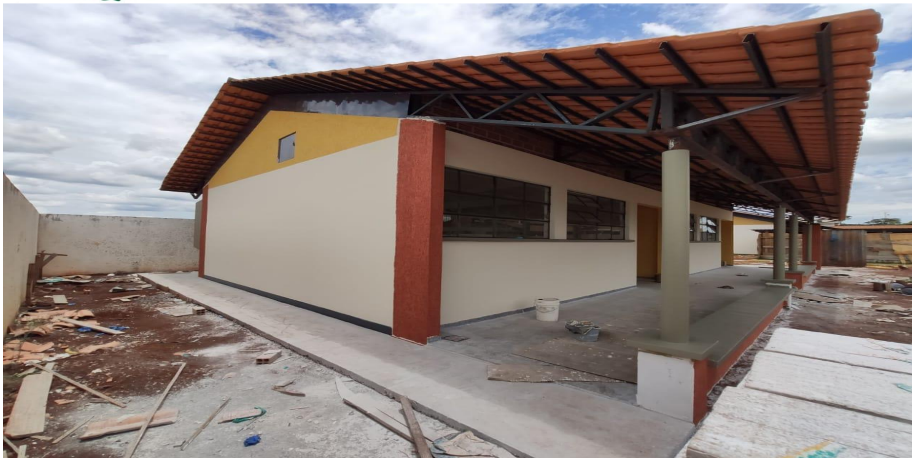
Construção de salas de aula.
