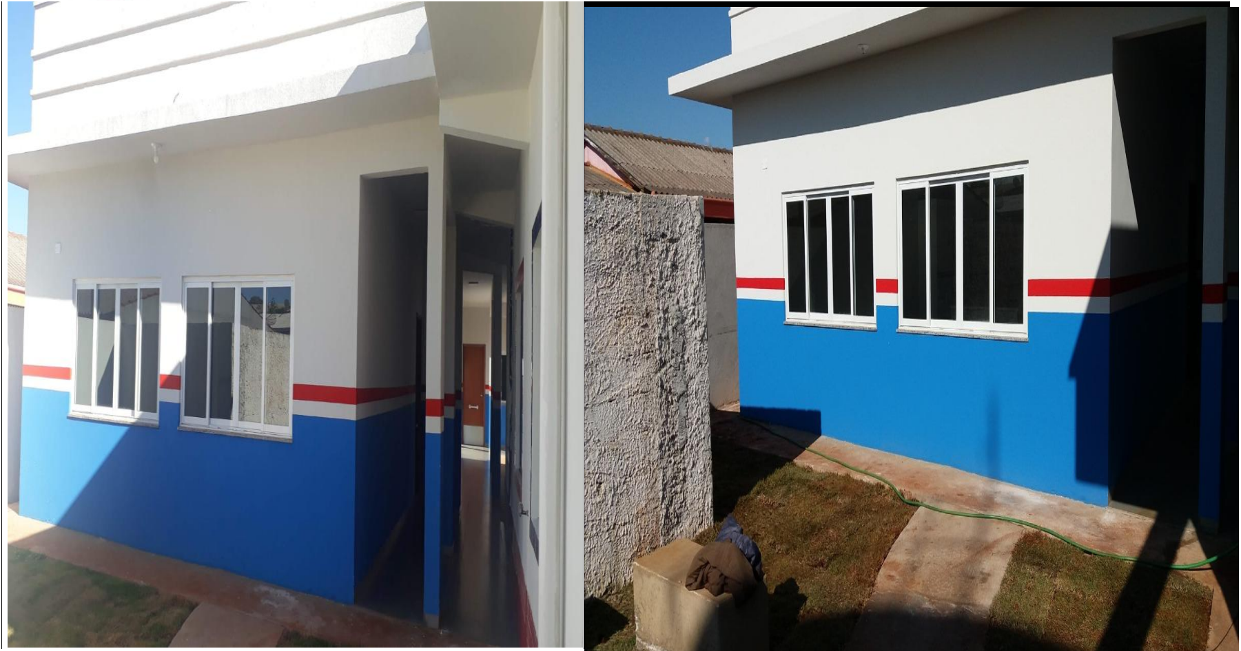
Construção de salas de aula.
