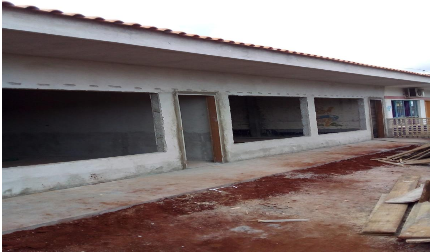
Construção de salas de aula.
