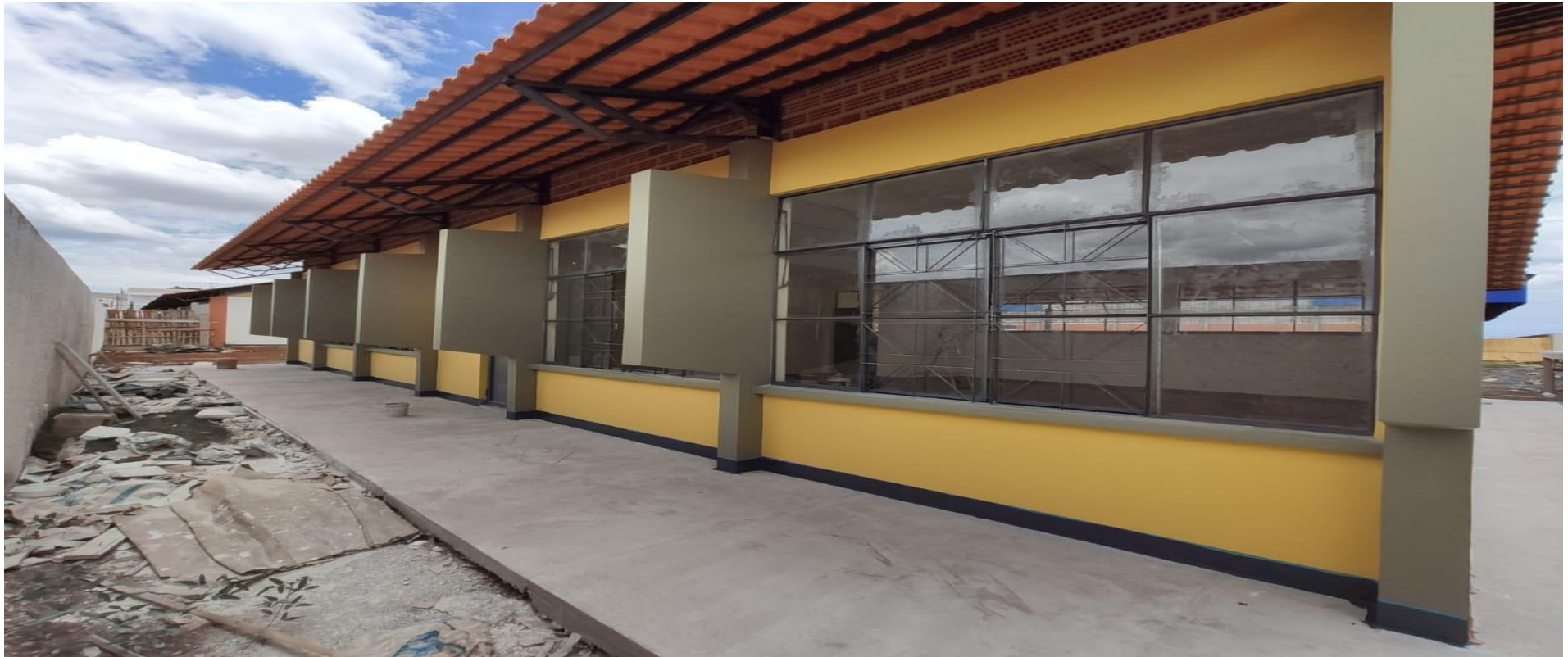
Construção de salas de aula.
