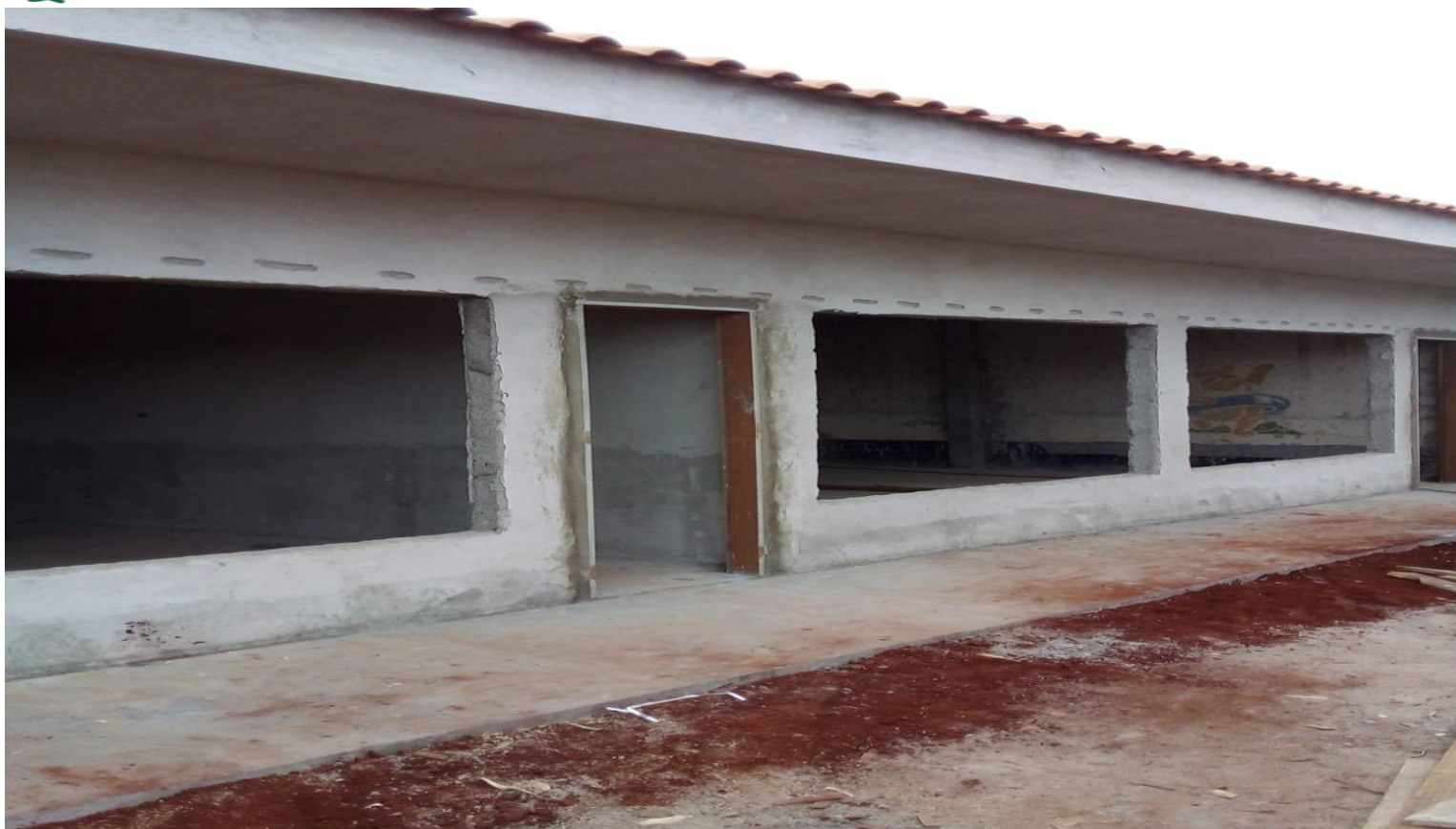
Construção de salas de aula.
