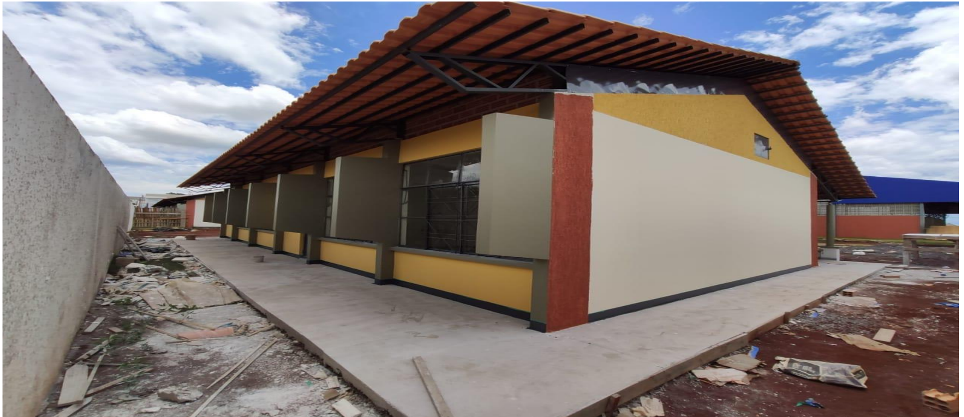
Construção de salas de aula.
