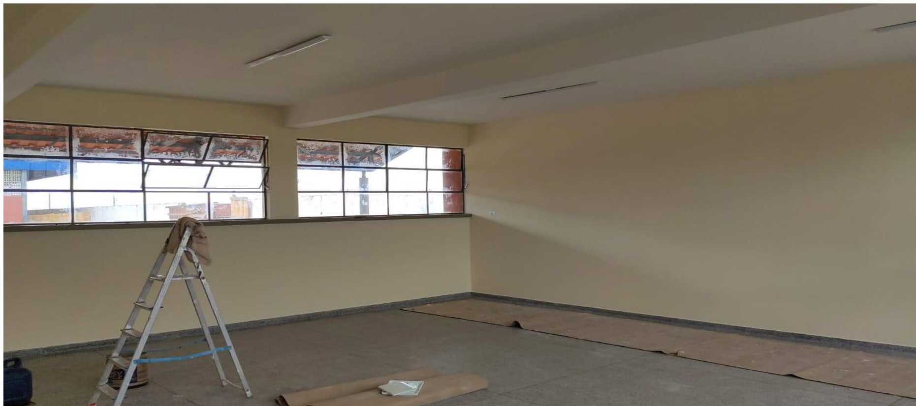
Construção de salas de aula.
